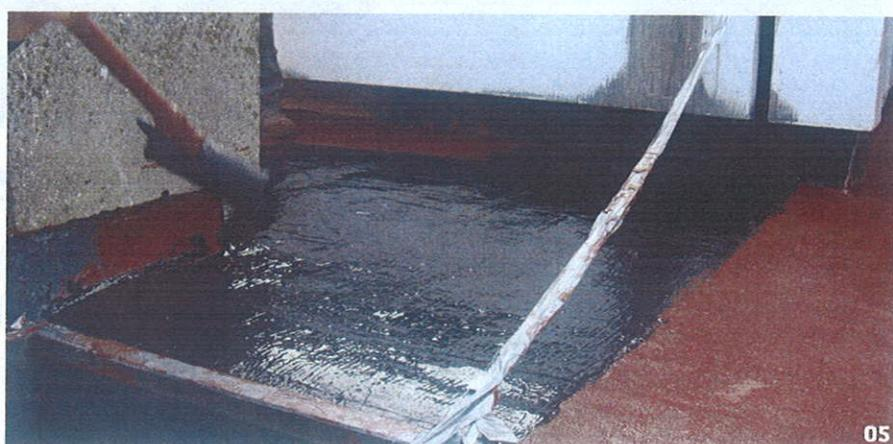
réparée, poncée mécaniquement puis nettoyée à haute pression en partie courante et en relevés. Comme pour l'évacuation des déchets, la livraison des matériaux d'étanchéité s'est effectuée par l'ascenseur. « Seules la première coursive et ses retombées d'étanchéité, zones les plus délicates du projet, ont été rénovées », détaille Éric Nantais de Sertec.
